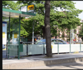
Raitioväylien aidat, Helsinki
